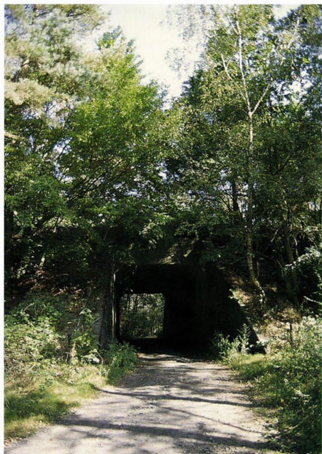
FIGUUR 1 Viaduct onder de spoordijk ter hoogte van de Hooibaan. Door de aanwezigheid van het oorspronkelijke Elvermersven is de spoorbaan hier verhoogd aangelegd. (foto: A.J.W. Lenders)
